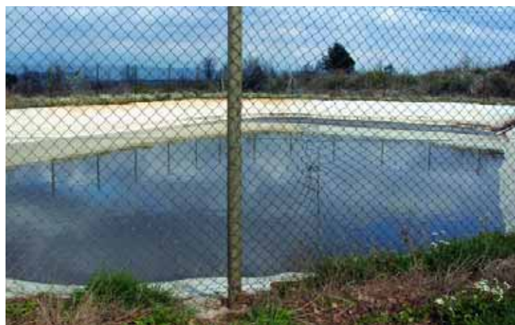
Balsa de purín impermeabilizada.
